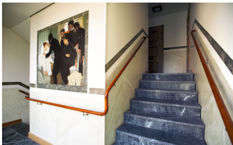
Marmor på golv i trapphus
