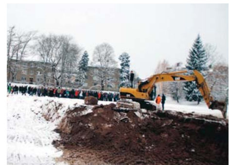
Eleverna fick lite hjälp av grävskopan.
