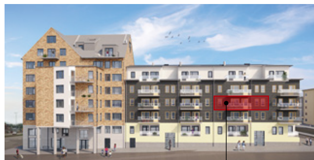
Fasad mot väster
