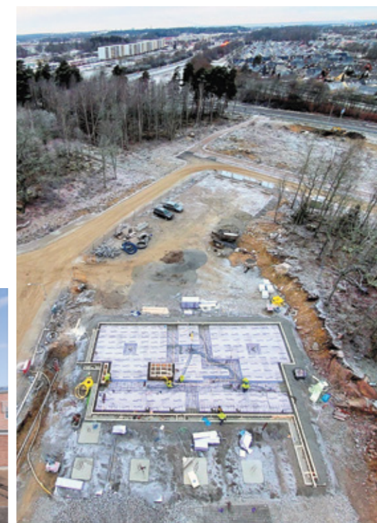
Byggnation av Skogsvallen i Linköping.
